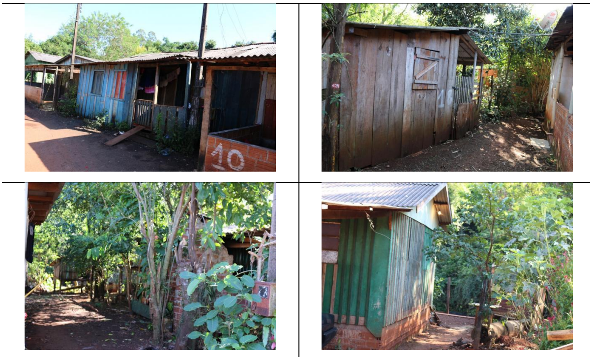
FIGURA 33: PADRÃO CONSTRUTIVO DAS MORADIAS DA VILA ALEGRIA
