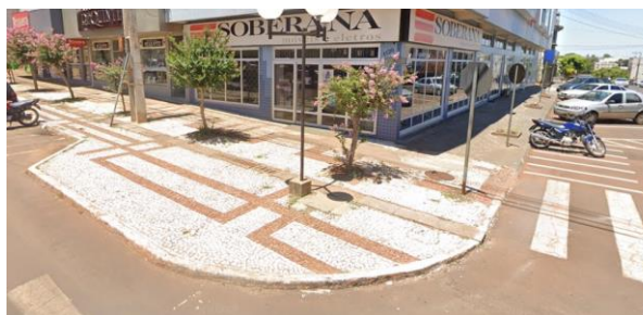
FIGURA 11: AUSÊNCIA DE ACESSIBILIDADE NA CALÇADA DA AV. BRASÍLIA
