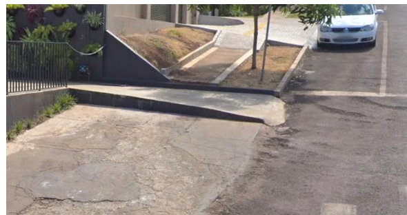
FIGURA 14: EXISTÊNCIA DE OBSTÁCULOS NA CALÇADA DA RUA MATO GROSSO
