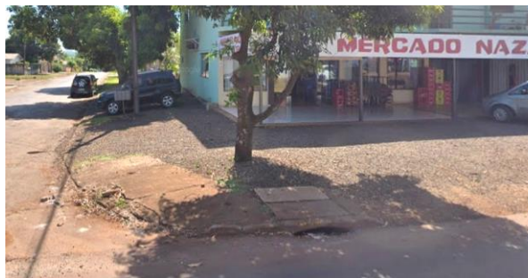
FIGURA 13: AUSÊNCIA DE ACESSIBILIDADE NA CALÇADA DA RUA IGUAÇU
